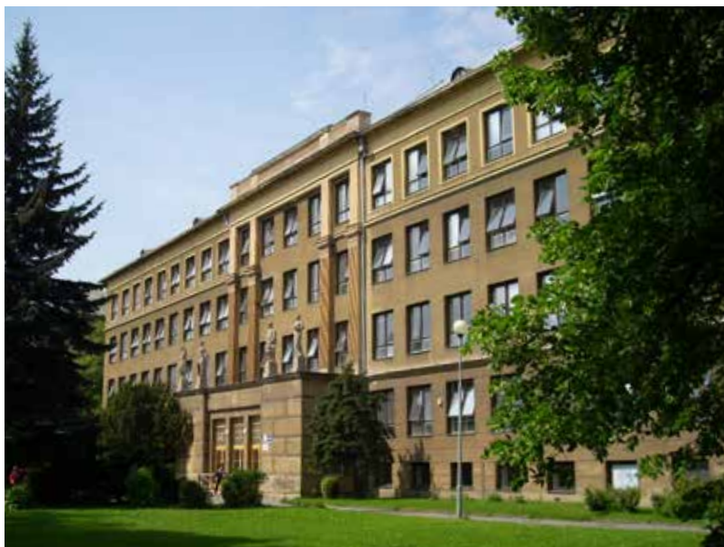
Budova Základní školy generála Zdeňka Škarvady, Ostrava - Poruba.
